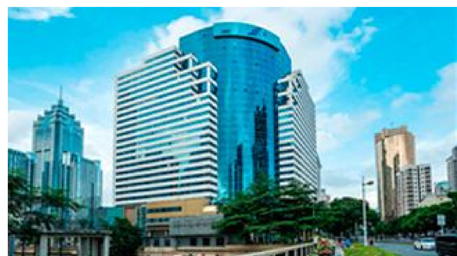
Старинное здание Тихоокеанской торговли в Шэньчжэне
